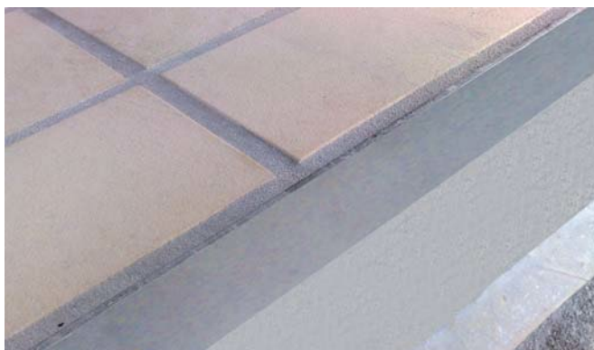
Esempio di posa paraspigolo terminale - Dis. N° 1004
